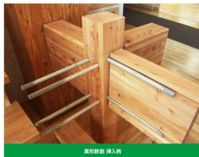
異形鉄筋 挿入例
